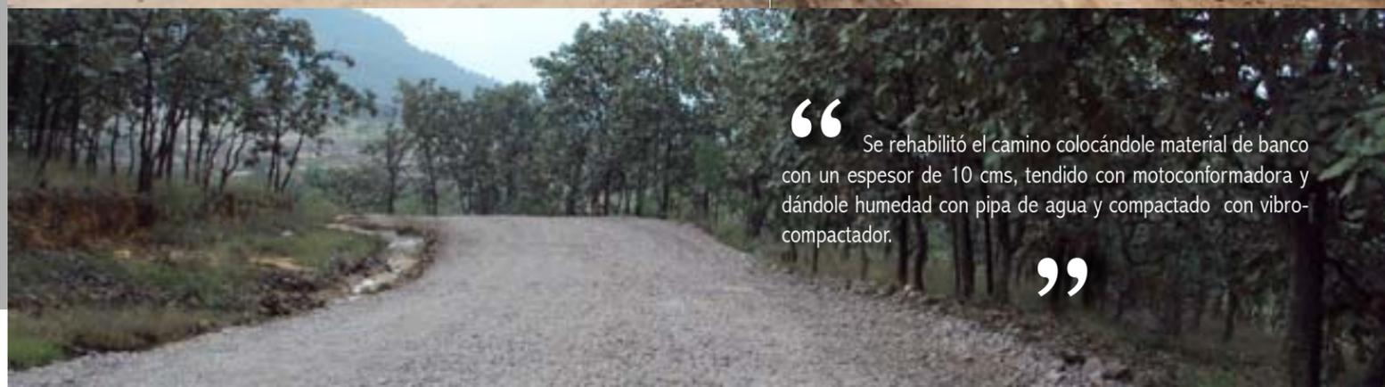
“ Se rehabilitó el camino colocándole material de banco con un espesor de 10 cms, tendido con motoconformadora y dándole humedad con pipa de agua y compactado con vibrocompactador. ”
